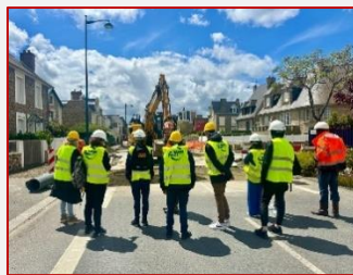
Visite entreprise de Travaux Publics avec COLAS, Fédération du Bâtiment et Constructys
